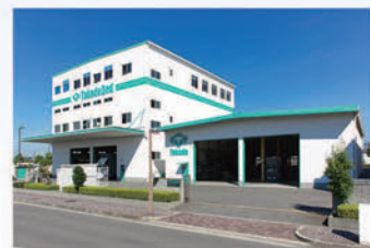
第三工場・第四工場
